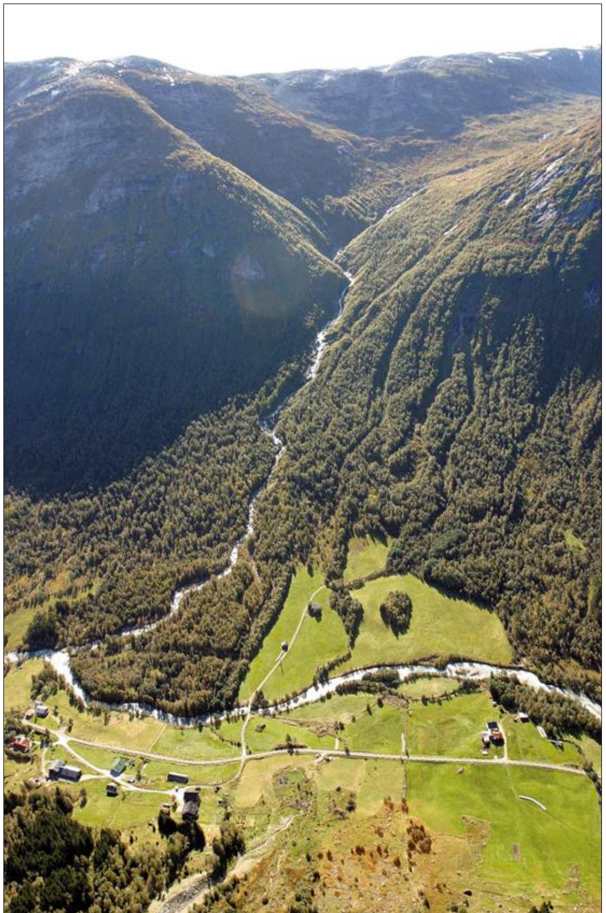
KRUNDALEN: Røykjedøla (biletet) og Tverrdøla, lenger framme, renn ned i Krundøla, hovudelva på biletet, dei to sideelvane skal etter Statkraft sin plan takast inn på nivå 540 meter.
