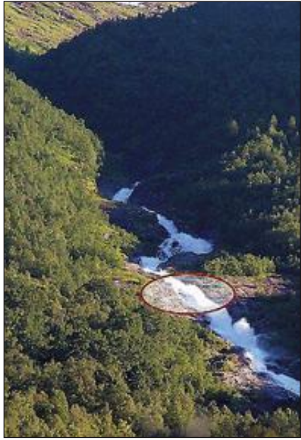
Røykjadøla med plasseringa av bekkeinntaket (illustrasjon ved aksjonen Vestsida-Vigdøla.no)
